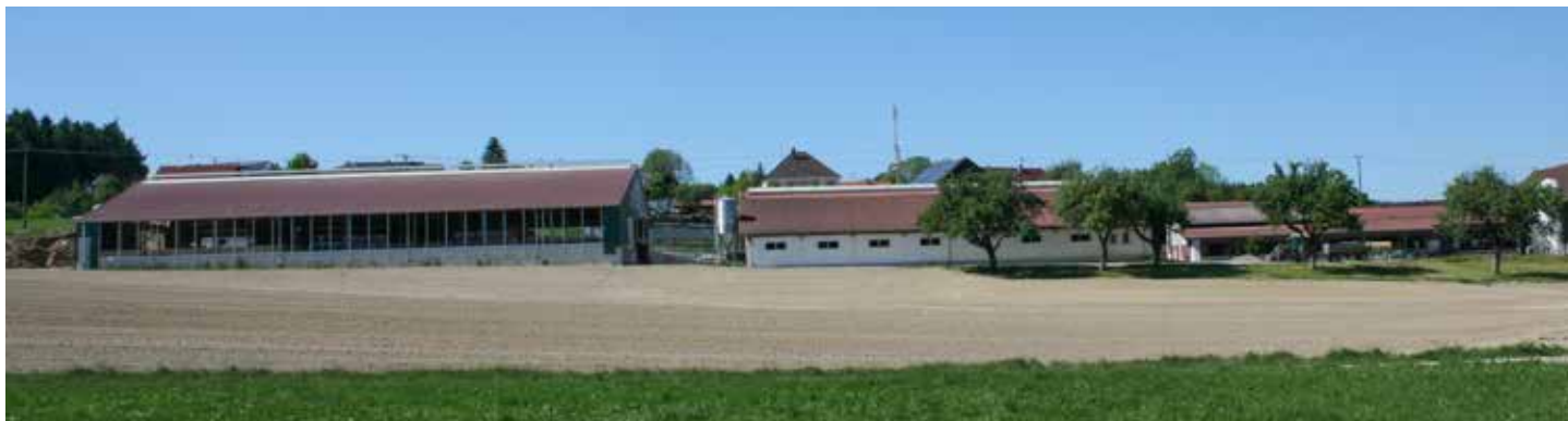
Die Entwicklung des Betriebes: rechts das ursprüngliche Hofgebäude, anschließend der 1976 gebaute Anbindestall, in der Mitte der 1998 gebaute Laufstall und links der neue Laufstall.
